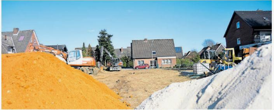
Spät kam der Wunsch nach einer Änderung des Bauplans. Die Bagger stehen bereits in dem kleinen Baugebiet an der Josefstraße in Heiden. Der Bau-Ausschuss lehnte die Anträge auch darum ab.
