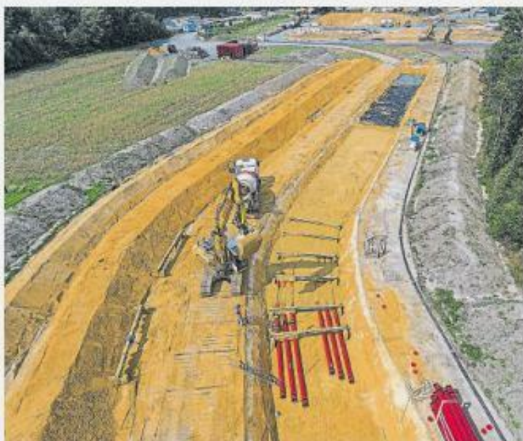
Arbeitsstreifen von bis zu 34 Meter Breite werden bei der Verlegung der drei Leitungen benötigt. Foto: pd
