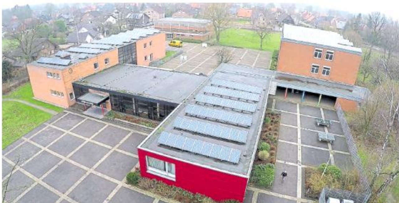
Im Sommer 2018 endet die Hauptschul-Ära. Im Westflügel (links) soll eine neue Kita entstehen, im östlichen Teil (rechts) ein „Haus der Begegnung“.
