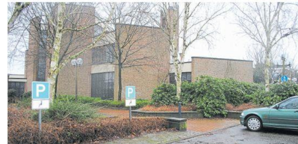
Die beiden Behinderten-Parkplätze würden nach jetzigem Plan für die Zufahrt zum neuen Parkplatz wegfallen.
