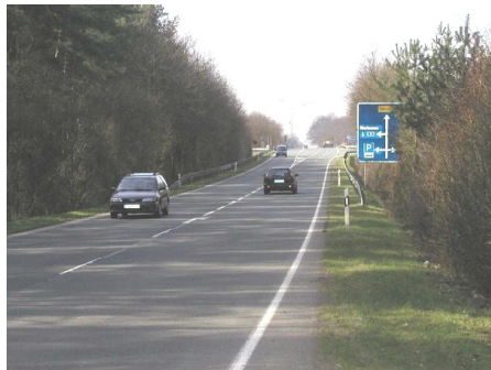
Direkt an der Autobahn 31 sollen 57 Hektar Gewerbefläche entstehen. (Foto: BZ-Archiv)
